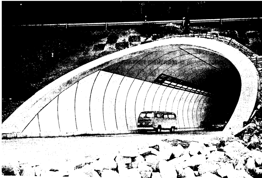
Sl. 5.36. Portal sagrađen po sistemu "cut & cover"
